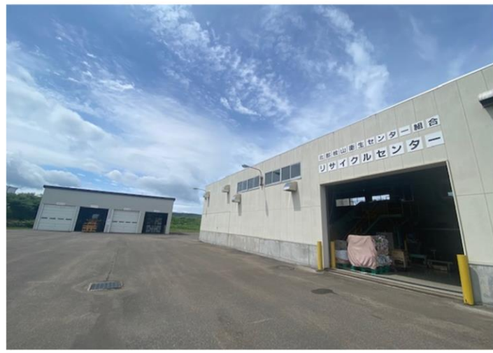
平成12年に建てられたリサイクルセンター
